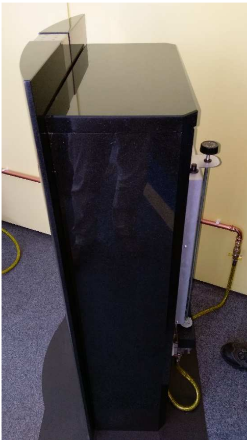
Pohled na sestavené topidlo a usazení kamenného obložení.
